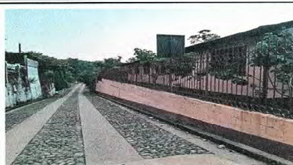
Foto 2: Sustitución de muro de malla por barandas de metal en muro perimetral
