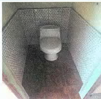
Foto 3: Sustitución de inodoro, piso cerámico y azulejo en modulo de baños
