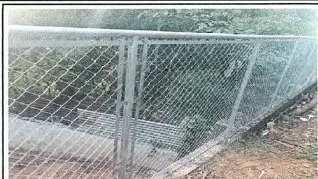
Foto 1: Reparación de tubo hg y malla galvanizada en muro perimetral
