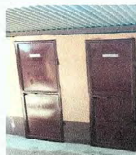
Foto 6: Mantenimiento a estructura de puertas de metal en modulo baños (lijado, cambio de tubo, etc.)
